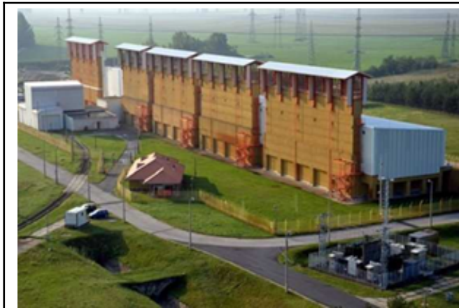
Figure 8 : Vue de l'entreposage MVDS du site nucléaire de Paks (Hongrie)
