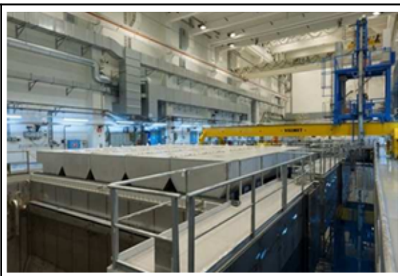
Figure 5 : Piscine d'entreposage dénommée TVO-KPA-STORE (site d'Olkiluoto – Finlande)
