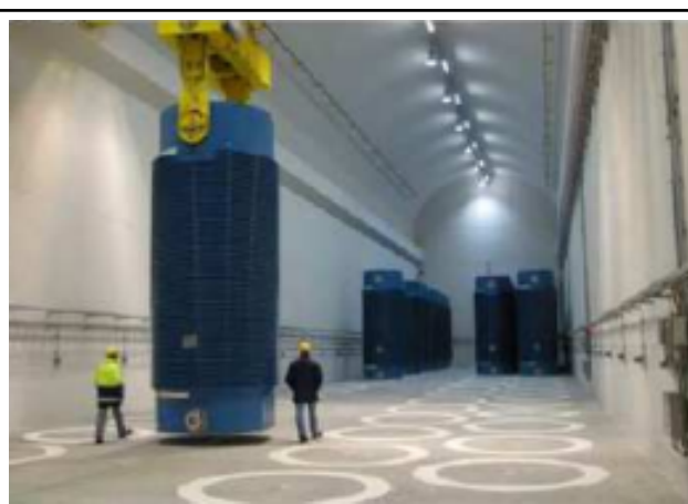
Figure 13 : Vue de l'entreposage des CASTOR® V/19 en tunnel de Neckarwestheim (Allemagne)
