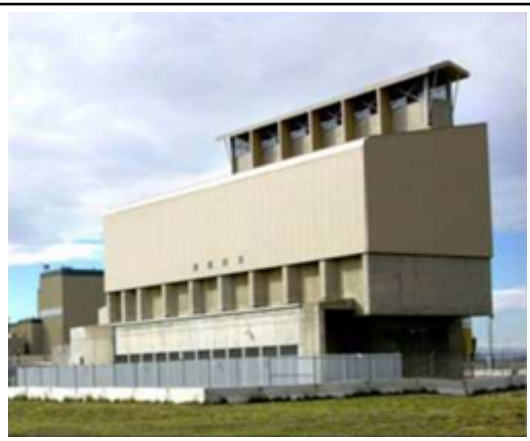
Figure 9 : Vue de l'extérieur de l'entreposage de type MVDS du Fort St. Vrain (États-Unis)
