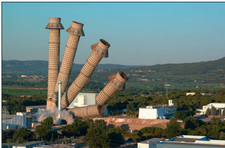
Le démantèlement de l'installation G1 à Marcoule
