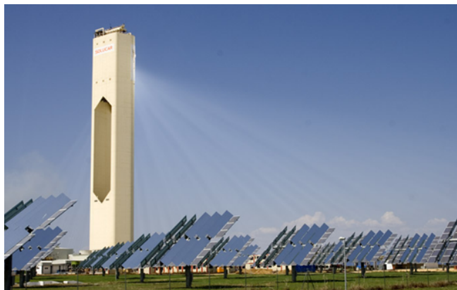
Figure 6 : Centrales PS10 (Séville)
