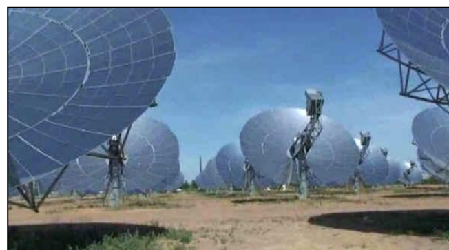
Figure 11 : Centrale de Maricopa
