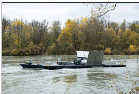
Figure 10 : Parc d'hydroliennes fluviales de Caluire
