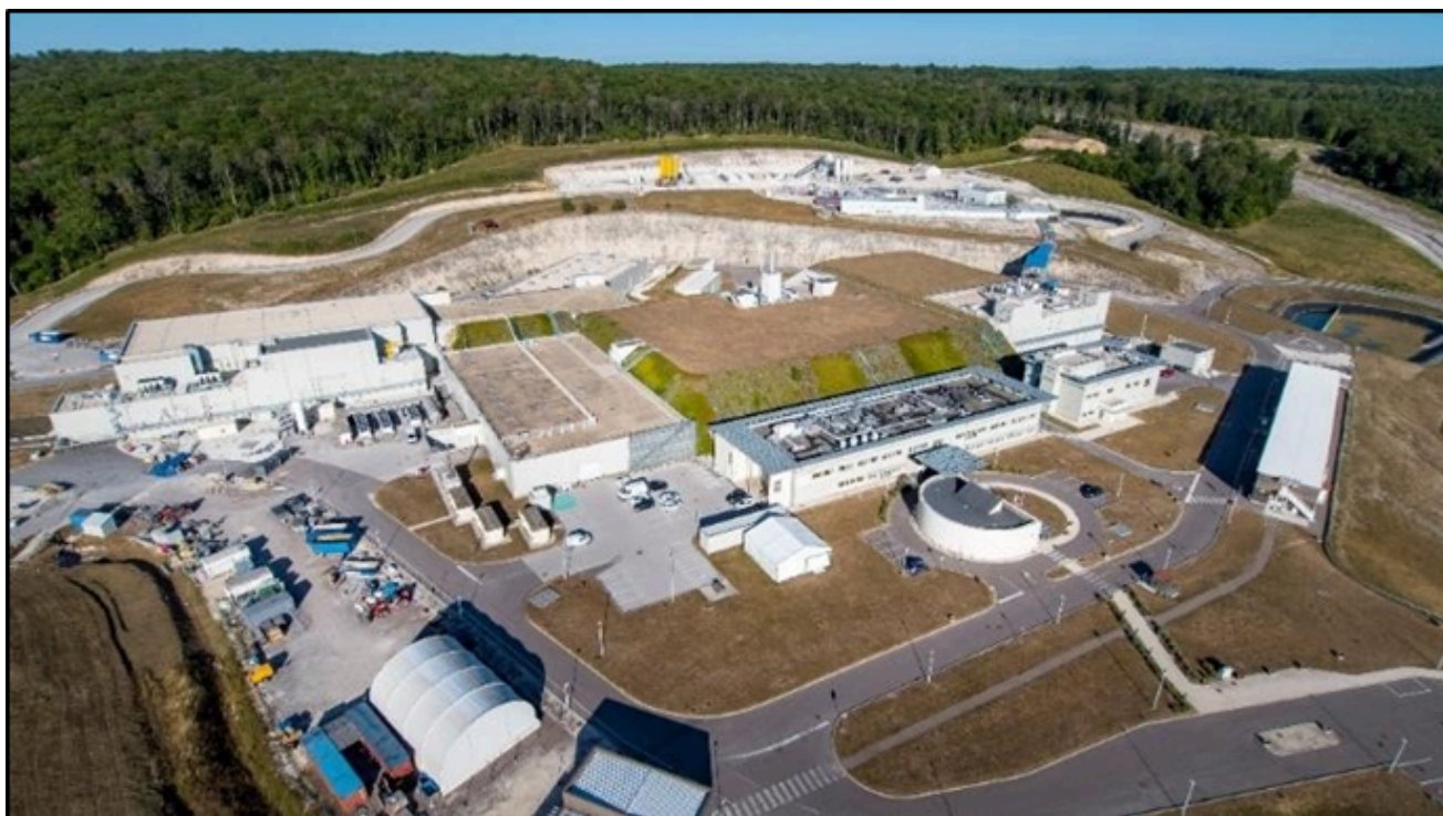
Installation EPURE du CEA
