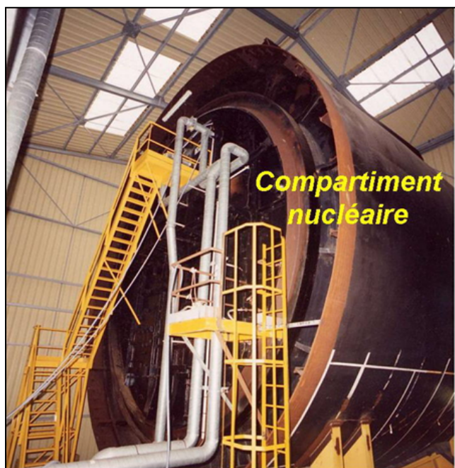
◀ Figure 10 : Découpage du compartiment réacteur
