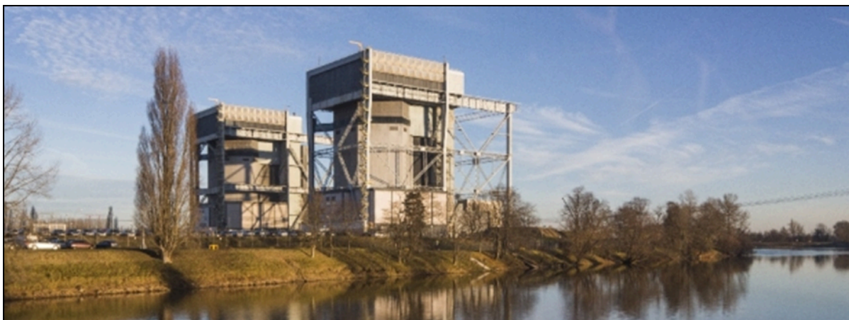
Vue des réacteurs A1 et A2 de la centrale de Saint-Laurent-Des-Eaux
