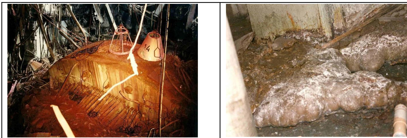
Figure 3 : Dalle du réacteur renversée
