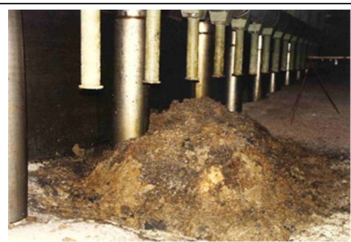
Figure 12 : Coulée de combustible sous le réacteur
