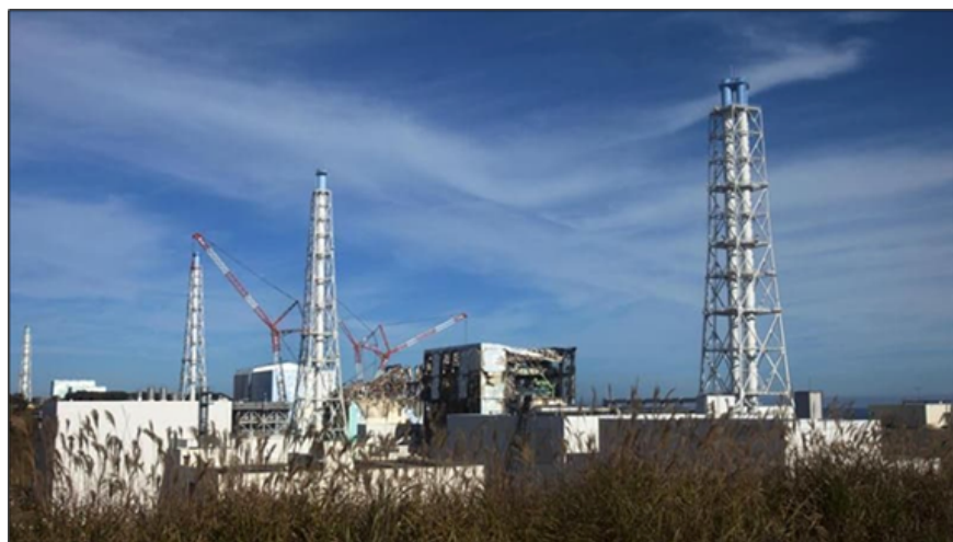
Site nucléaire des réacteurs accidentés de la centrale de Fukushima Daiichi
